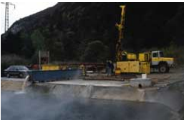
Fig. 7-32: Pumpversuch in der Tiefbohrung von Lavey-les-Bains (VD). Die Austrittstemperatur des Wassers beträgt 68 °C.
